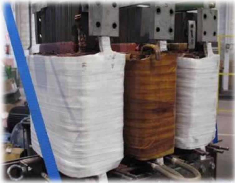
REPARACIÓN DE TRANSFORMADOR REFRIGERADO POR AGUA
